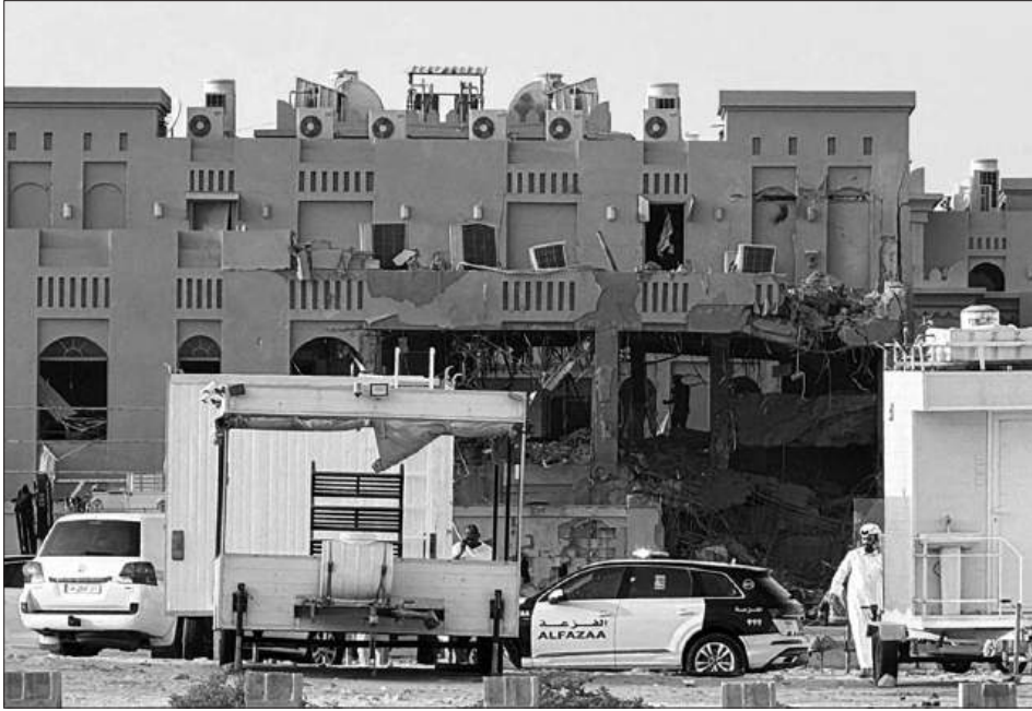
Một tòa nhà bị hư hại sau cuộc tấn công của Israel vào các thủ lĩnh Hamas ở Doha, Qatar, ngày 9/9/2025.
